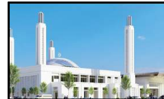
Pembinaan Sebuah Masjid 2 Tingkat, Eco Ardence.
